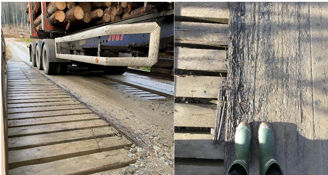
Figur 10. Vänster: Lastbilens position vid överfart. Höger: Närbild av yttre slitplank.
