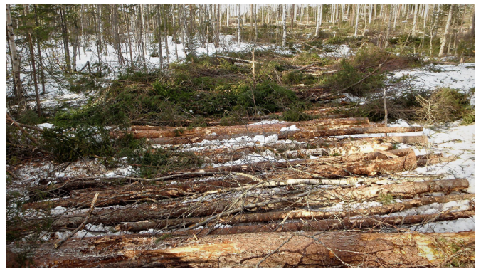
Figur 2. Kavelbro av massaved över en myrhaps, körbanan täcks med grot. Foto: Tomas Nordfjell.
