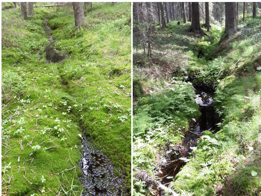
Figur 3. Exempel på ett dräneringsdike (tegdikey; vänster) och ett huvuddike (höger) i skogsbestånd i Sverige där den initiala dikningen har främjat skogstillväxten. Några sträckor i diken har lämnats orensade och sedimentationsgropar har grävts var 100:e till 200:e meter längs diken. Foto: Bo Leijon.
