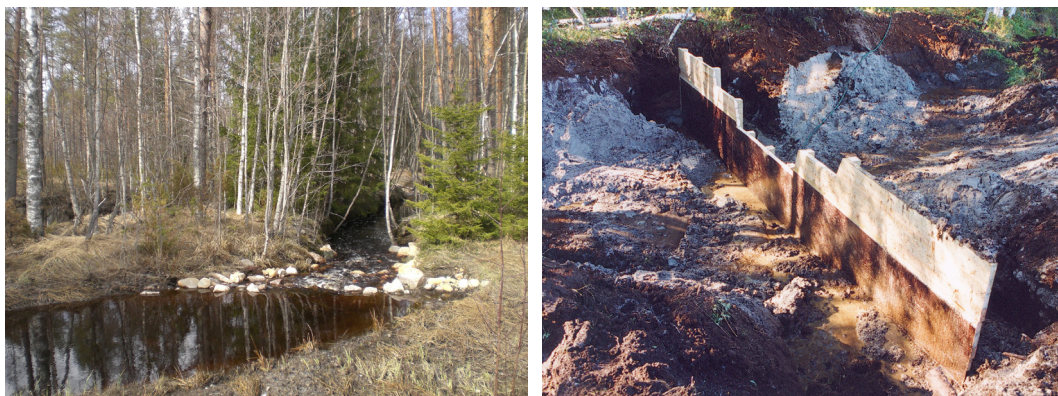
Figur 6. Till vänster en fungerande bottendamm och till höger en under uppbyggnad där man ser stödväggen i den blivande dammvallen. Väggen placeras tvärs över diket, i mitten av bottendammen, där vattenhastigheten förväntas vara hög. Foto: Leena Finér (vänster) och Matti Seppälä (höger).
