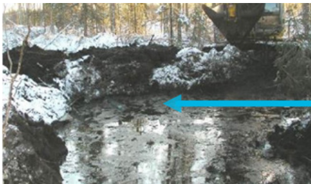
Figur 11. Installation av en rördamm (flödesreglerande konstruktion med sedimentationsdamm) steg för steg: a) grävning av en sedimentationsdamm uppströms rördammens dammvall, b) röret för basflödet installeras (med ett vinklat inlopp för att hindra eroderade partiklar att komma in i röret), c) dammvallen förseglas med jord (torv), och d) konstruktionen är färdig och i funktion. Observera att inget övre rör för högflöden finns i denna rördamm. Foto: Juha Jämsén.
