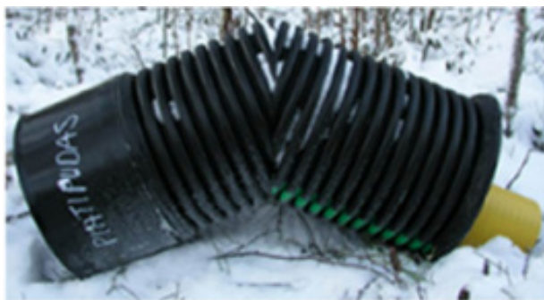
En rörreducerare installerad i änden på en rörvinkel
