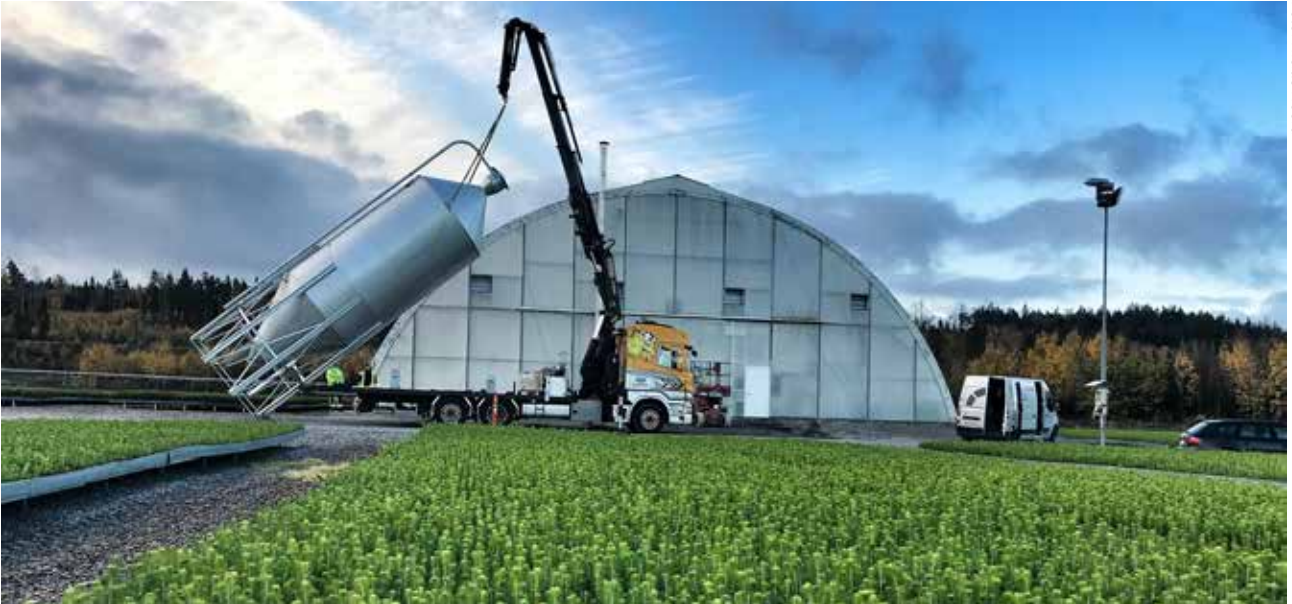
Växthusnäringen har i stor utsträckning ersatt eldningsolja med biobränslen. Här lyfts en pelletssilo på plats vid ett av Svenska Skogsplantors växthus.
