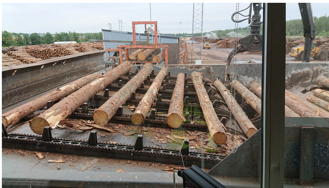
Figur 6. Vy över passerande stockar från kontrollstolspositionen på en sågverksmätplats. Mätramen sitter i den gråblå byggnaden i bakgrunden. Källa: Kari Hyll.
