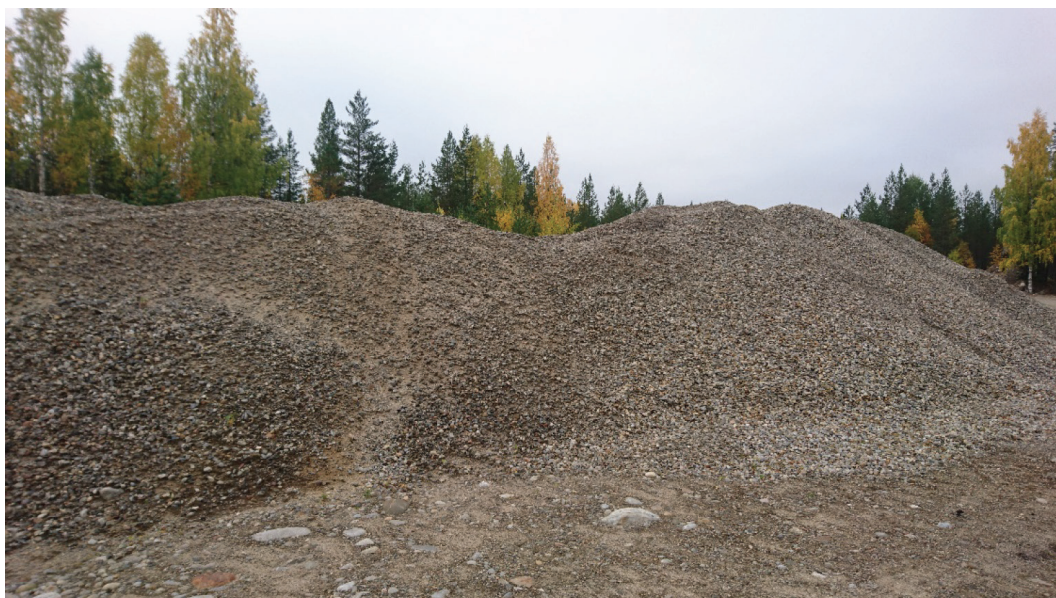
Figur 10. Grusupplaget, material för bärlager på skogsbilvägar, materialstorlek 0 – 40 mm. Fotot taget vid vita pilen i figur 8.
