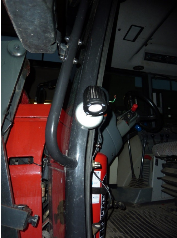
Figur 17. Bilden visar LED-armaturens placering intill dörren med hjälp av magnetfoten.
