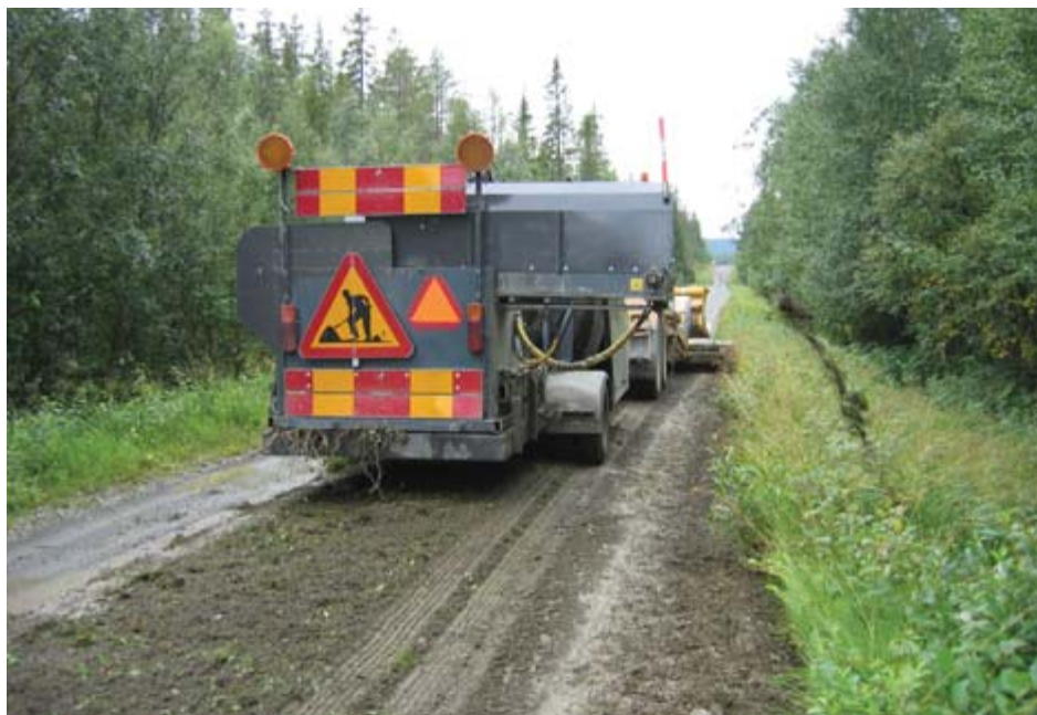
Kantskärning och återvinning av grus med Mählermetoden. Restmaterial läggs på utsidan av diket. Foto: Claes Löfroth.
