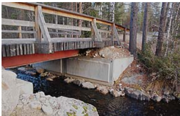
Stålbalksbro med betongfundament. Foto: Per Hallgren.
