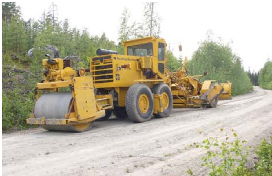
Vibrerande slätvält på väghyvel. Foto: Fredrik Staland.
