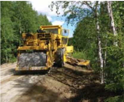
Väghyvel med dikningsvinge och vält. Foto: Fredrik Staland.
