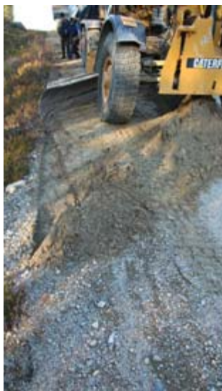
Kantskäring återför gruset till vägbanan. Foto: Claes Löfroth.
