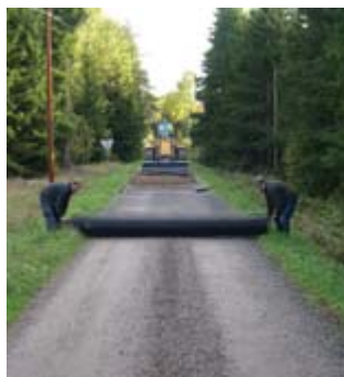
Passager med dålig bärighet kan förstärkas med geonät. Foto: Claes Löfroth.
