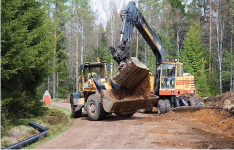
Breddning av kurvan i samband med trumläggning. Foto: Thomas Adolfsén/Skogenbild.
