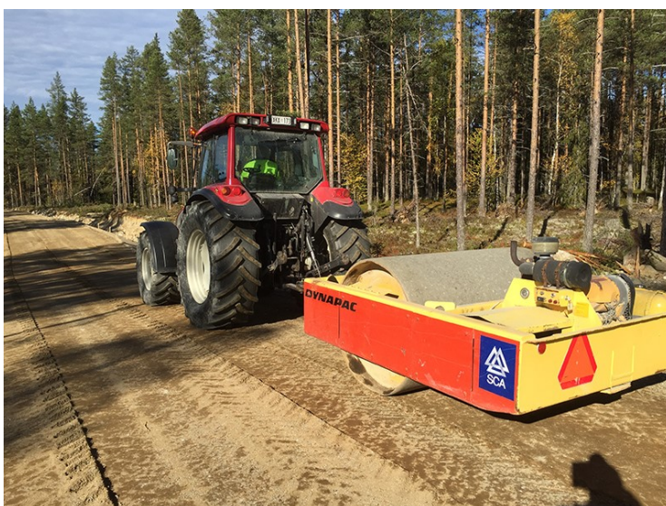
Figur 12. Kompaktering av terrass, Försöksväg 3.
