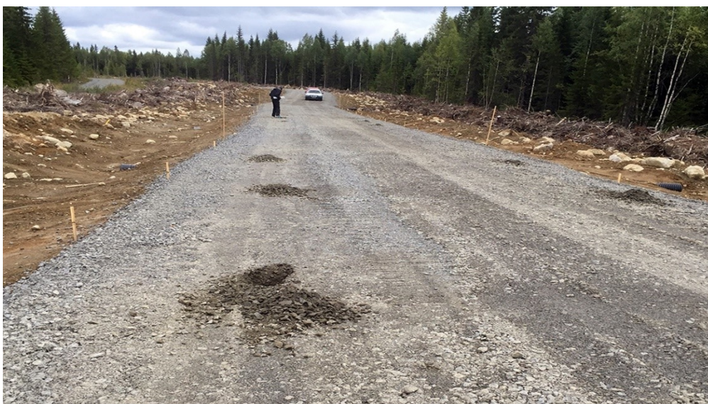
Figur 16. Mätning av grustjocklek.
