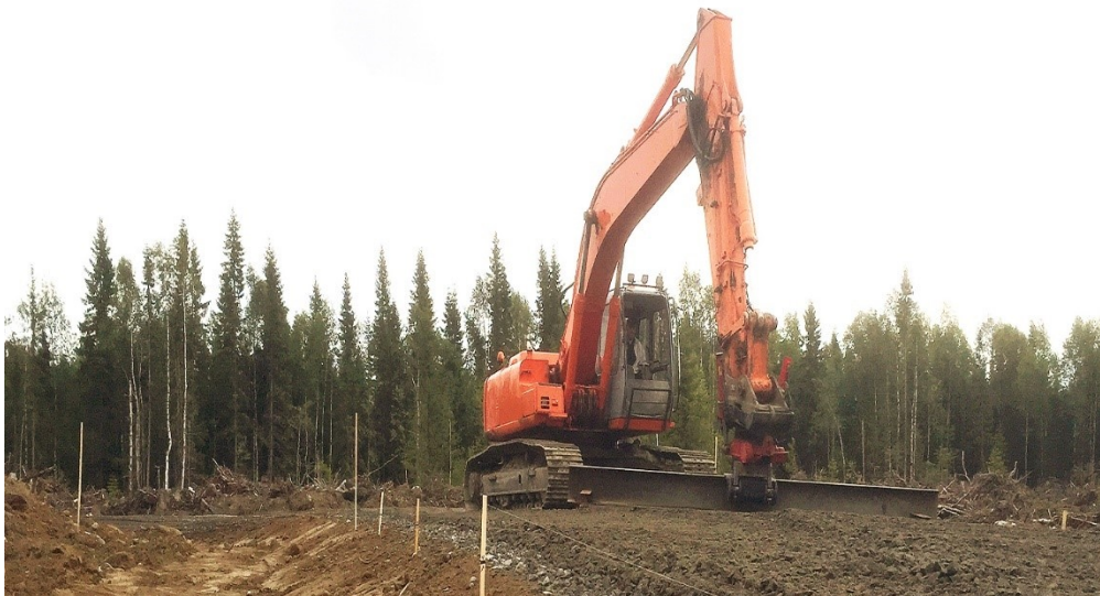
Figur 15. Justering av överbyggnad med justerbalk.
