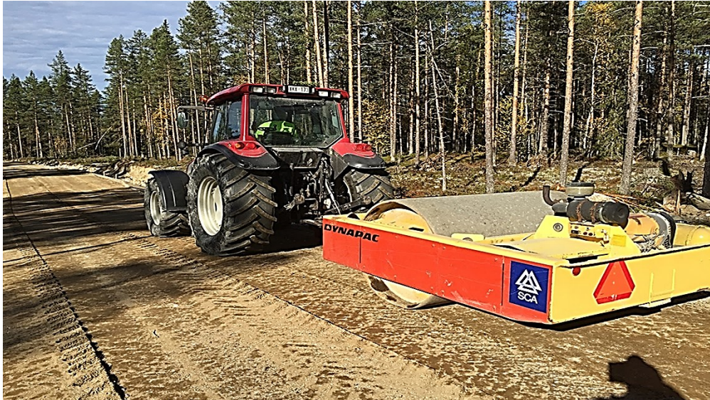
Figur 24. Packning av terrass – Försöksväg 3.
